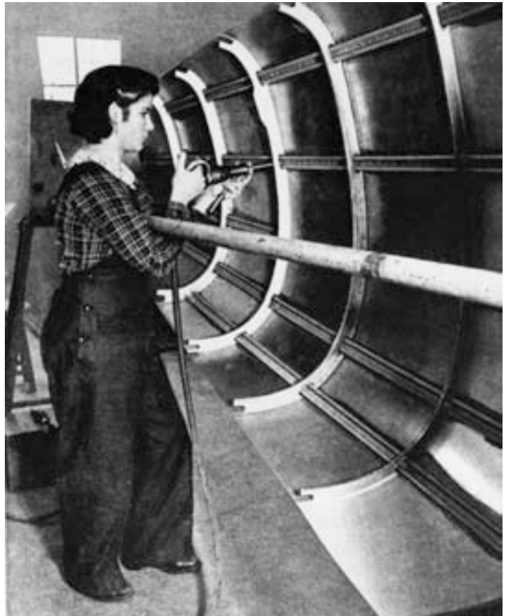
Nietarbeiten an einer Rumpfhalschale Me 109. (Foto Archiv Airbus Defence)
