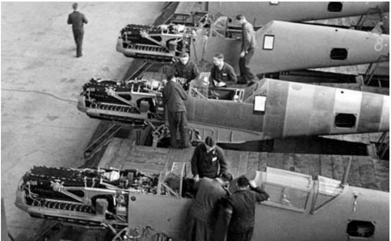
Rumpfmontage der Me 109 E in Regensburg. Bemerkenswert an dieser Aufnahme ist der Rumpf in der Mitte, der über keine Lackierung verfügt. (Foto Archiv Airbus Defence)
