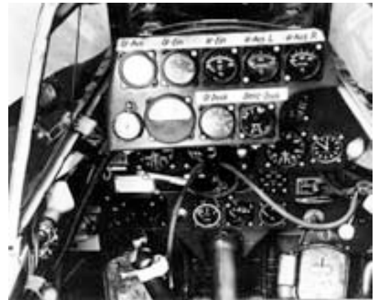
Blick auf das Instrumentenbrett der V-13 mit vielen zusätzlichen Instrumenten zur Triebwerksüberwachung des DB 601 A. (Foto Archiv Airbus Defence)
