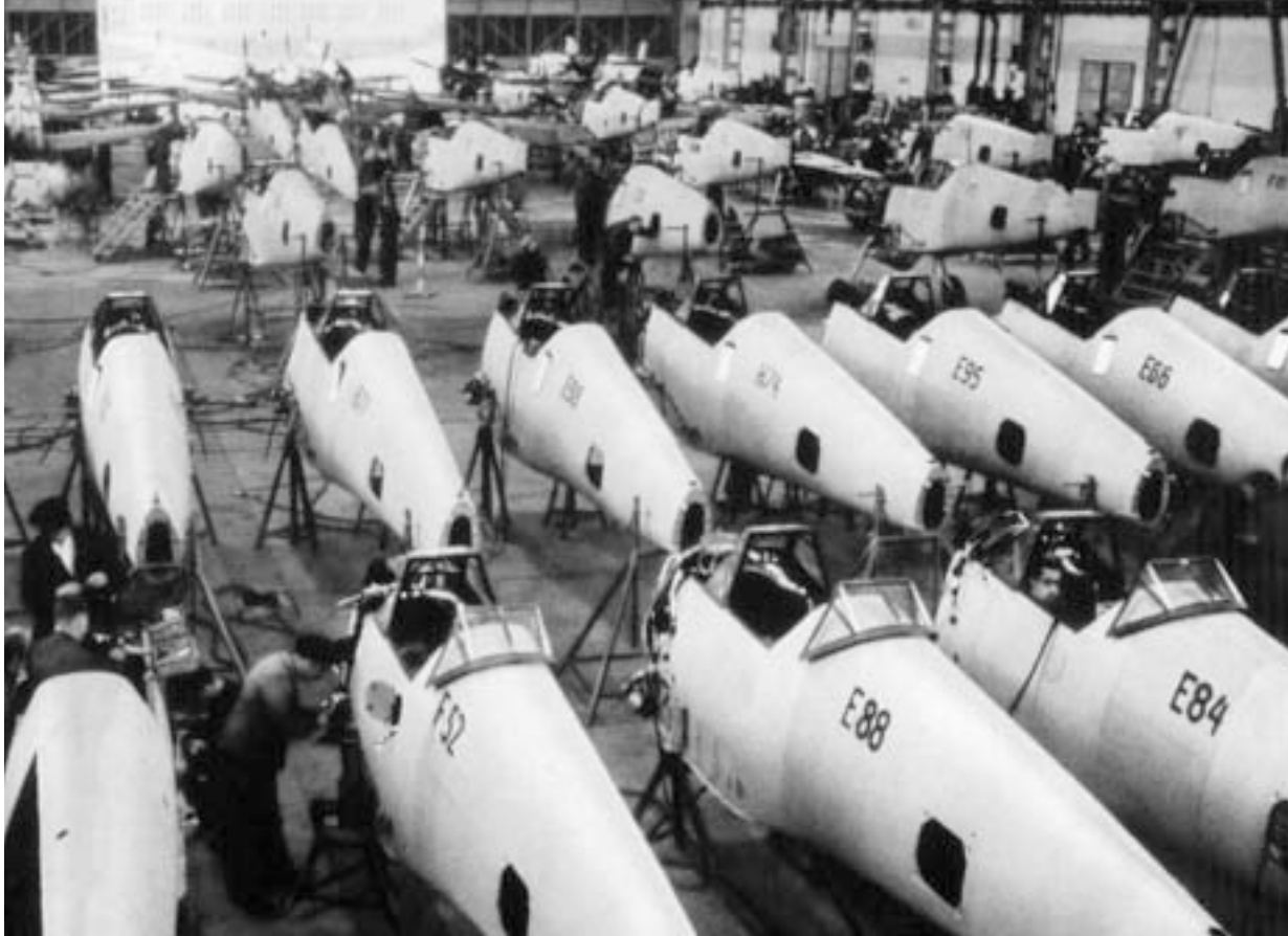
Aufnahme der Endmontage von hinten. Zahlreiche Rümpfe stehen für den weiteren Zusammenbau bereit.
