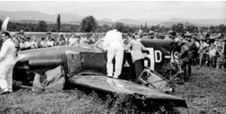
Bei einem Flugmeeting in Zürich flog der damalige Generalmajor Udet die Me 109 V-14. Aufgrund eines Triebwerksausfalls wurde eine Notlandung erforderlich, bei der das Flugzeug so schwer beschädigt wurde, dass es als Totalschaden abgeschrieben werden musste. (Foto Archiv Airbus Defence)
