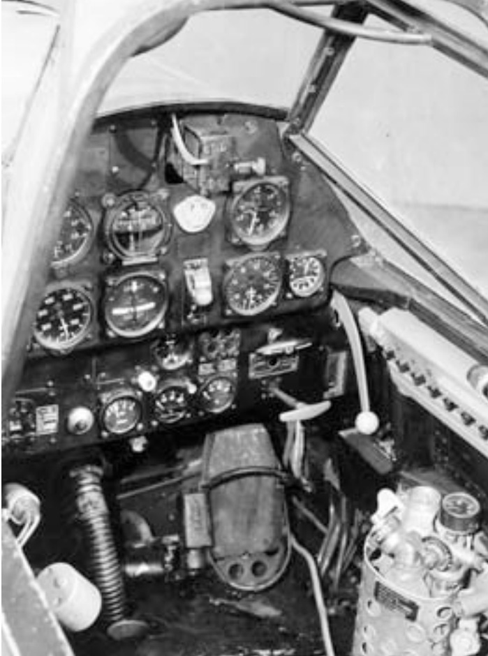
Blick in die Kabine und auf das Instrumentenbrett einer Me 109 E. Unten rechts ist der Höhenatmer für die Sauerstoffversorgung des Flugzeugführers eingebaut. (Foto Archiv Airbus Defence)
