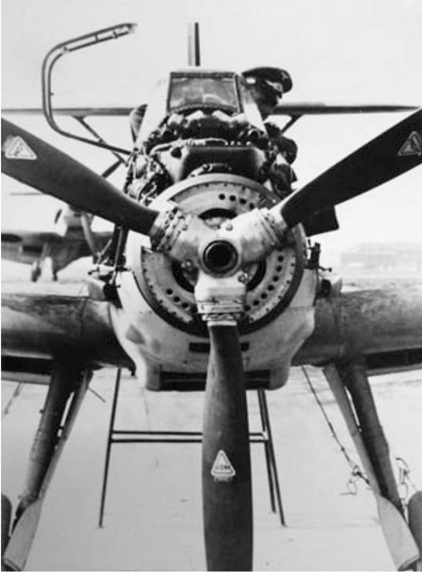
Frontalansicht einer Me 109 E. Die Luftschaube, von VDM hergestellt, hat einen Durchmesser von 3100 mm. (Foto Archiv Airbus Defence)
